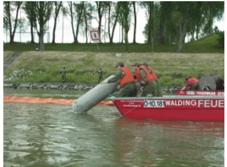
und dann mit einer Seilwinde zu einer sackförmigen Schlaufe gekrümmt. Beim Zusammenziehen der Schlängelleitungen zeigte sich die Intensität der freiwerdenden Kräfte. Nur durch den Einsatz einer Seilwinde konnten die Ölsperren sackförmig zusammengezogen und am Ufer befestigt werden.
