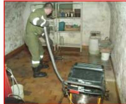
Durch den Einsatz einer Tauchpumpe konnte das Wasser rasch abgepumpt werden. Nach der Verwendung des Wassersaugers blieb auch der Schaden minimal, sieht man von den Folgearbeiten wegen des Rohres ab.
