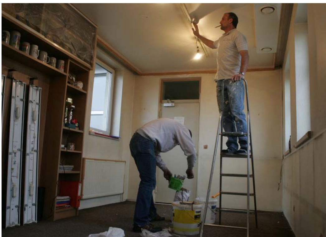
Eine der Aufwände im Bereich des Dienstbetriebes: In Eigenregie wurde Ende Dezember 2007 der Aufenthaltsraum neu gestrichen sowie anschließend ein Parkettboden verlegt.
