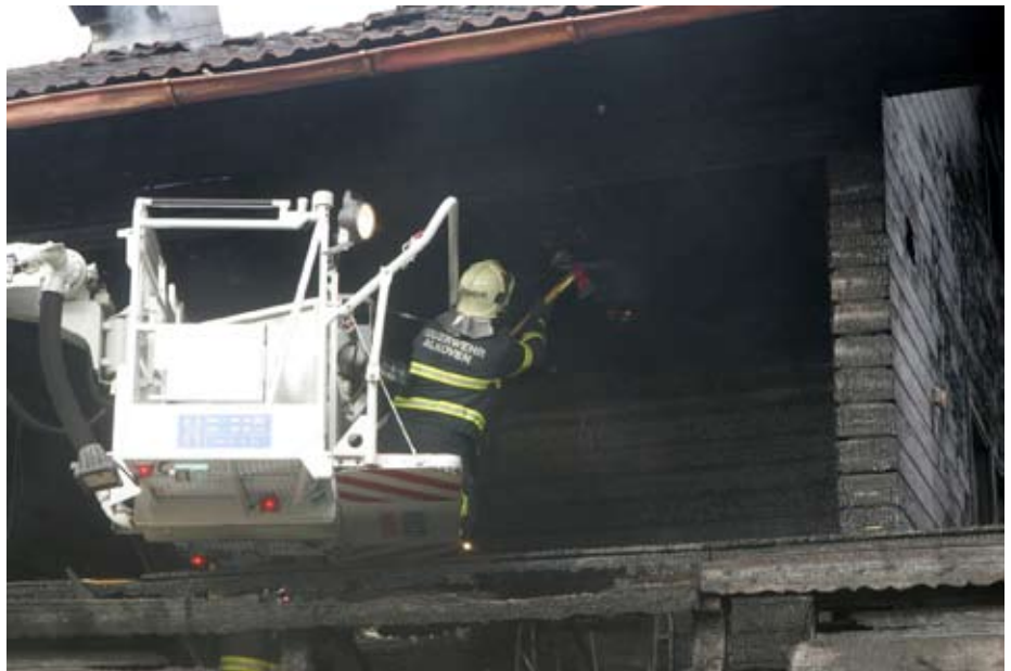
Öffnen der Wand, um versteckte Glutnester lokalisieren zu können. Die TMB leistete bei diesem Einsatz ausgezeichnete Dienste.
